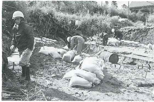
▲ 冬の小松原砂防工事
