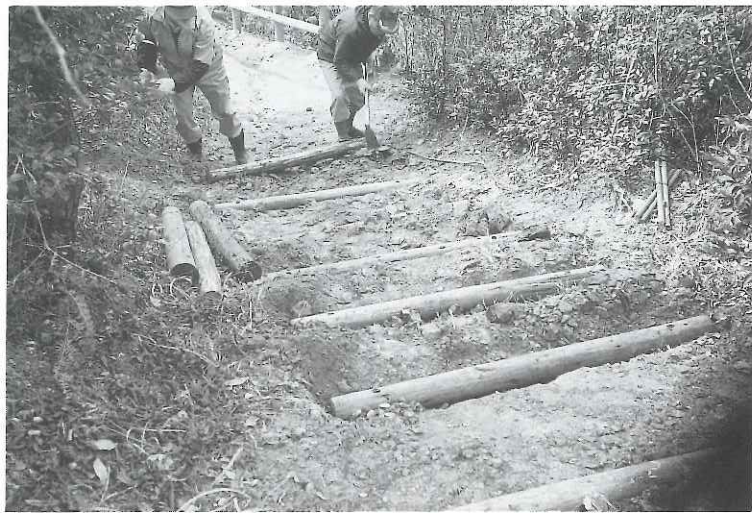
▼田床山遊歩道の改修
