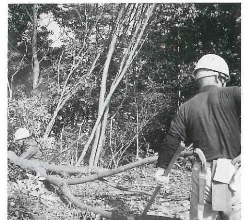
▲赤崎公園地造成
