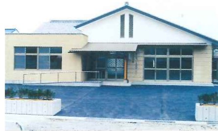
ワークプラザ萩 完成
